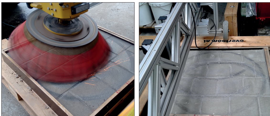
Figuur 27 – Proeven ter bepaling van de erosiegevoeligheid van de voegmortels (stalen onkruidborstel en laserprofielmeter om de voegprofielen voor en na borstelen te bepalen)
