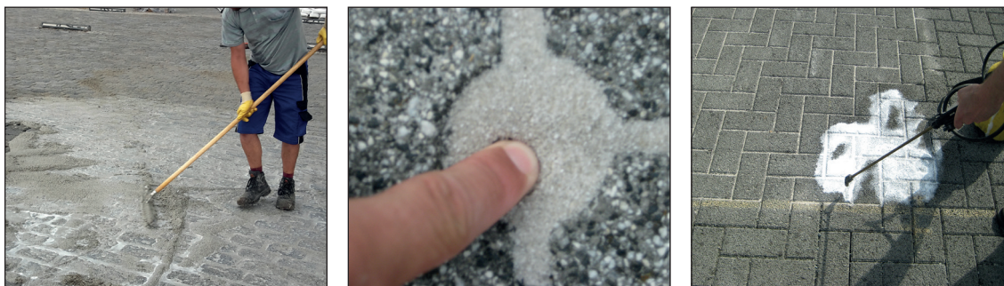
Figuur 3 – Voorbeelden van innovatieve(re) voegvullingsmaterialen (van links naar rechts: epoxygebonden voegmortel, polymeerzand en joint sealer)
