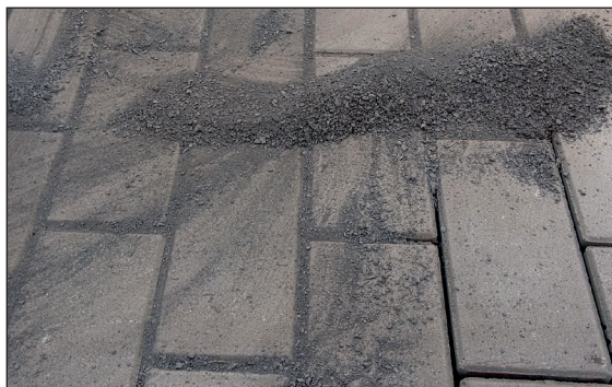
Figuur 24 – Proefbakken met trilplaat ter bepaling van toepasbaarheid van voegmaterialen
