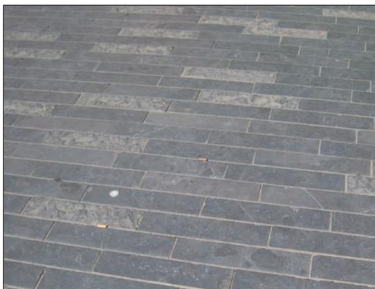
**Figure 3.29** – Revêtement alternant de la pierre naturelle polie et brute. Au regard des surfaces polies existantes, le risque de glissance reste présent<sup>6</sup>
