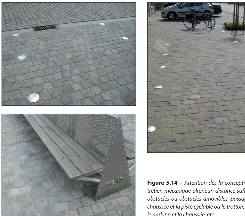
**Figure 5.14** – Attention dès la conception pour un entretien mécanique ultérieur: distance suffisante entre les obstacles ou obstacles amovibles, passage aisé entre la chaussée et la piste cyclable ou le trottoir, filet d'eau entre le parking et la chaussée, etc.
