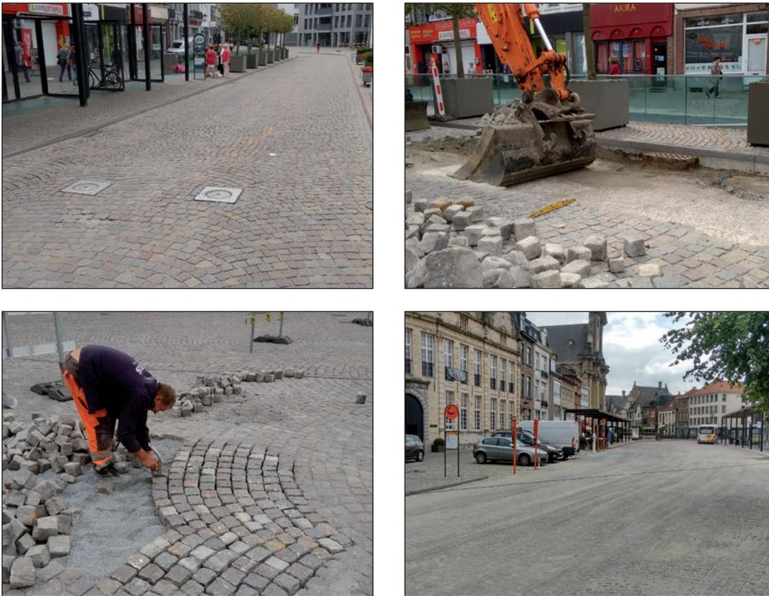
**Figure 5.21** – Pavage en pierre naturelle avant, pendant et après rénovation avec réutilisation de pavés en granit suédois
