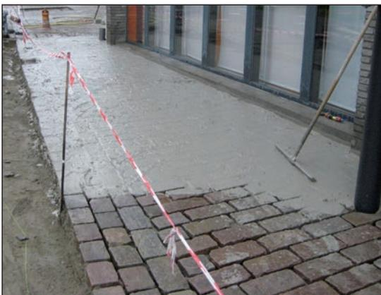
Figure 2.11 – Mise en œuvre de mortier modifié
