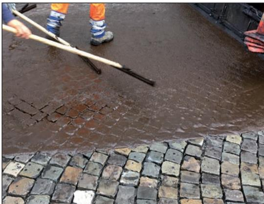
**Figure 4.15** – Remplissage des joints au mortier bitumineux
