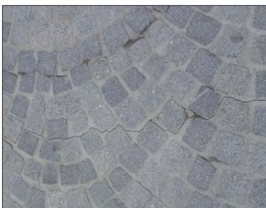
**Figure 5.5** – Des fissures dans des joints liés au ciment sont une dégradation fréquente dont les causes peuvent être multiples
