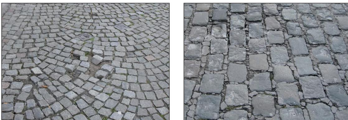
**Figure 5.8** – Exemples de déformations locales dues à une exécution peu soignée et/ou à des défauts de conception
