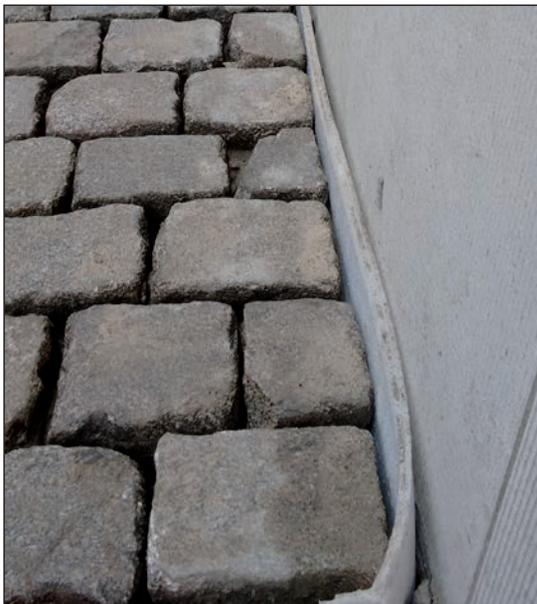
**Figure 3.20** – Joint d'isolation séparant le mur d'habitation du trottoir
