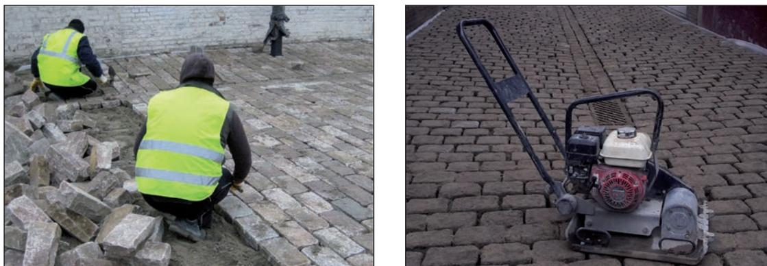
**Figure 4.5** – Nichage des pavés dans la couche de pose, suivi du compactage
