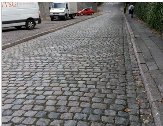
**Figure 4.3** – Exemple de contrebutage transversal dans une rue en pente
