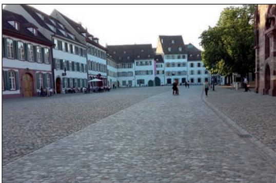
**Figure 3.30** – Bande de confort en pavés sciés sur une chaussée en pavés classiques
