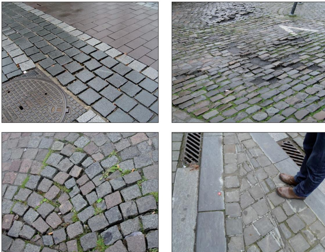
**Figure 5.4** – Exemples de perte de cohésion structurelle du revêtement due à des joints trop larges, à un appareillage inadapté, à l'absence de contrebutage et/ou à une finition non soignée aux bords et autour des points singuliers
