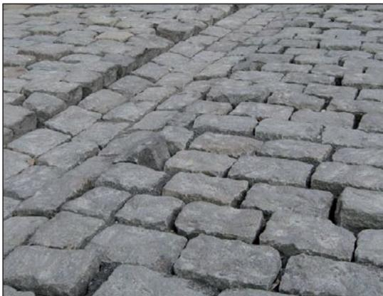
**Figure 3.17** – Exemple d'incompatibilité entre le matériau de jointoiement et la couche de pose: combinaison d'une couche de pose rigide en sable-ciment et des joints souples en sable perméables où l'eau, le gel et le trafic provoquent le déchaussement des pavés
