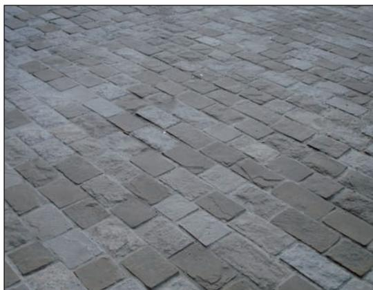
**Figure 3.27** – Pavés en pierre naturelle peu confortables vu les multiples défauts d'uni<sup>5</sup>
