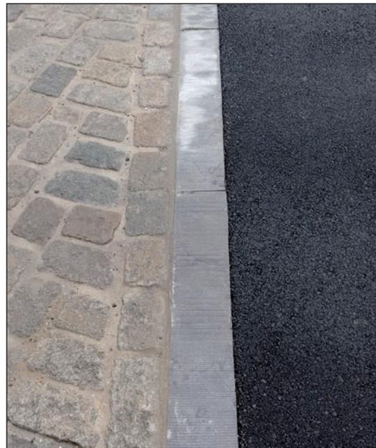
Figure 3.22 – Bordure à la transition entre un revêtement bitumineux et un pavage en pierre naturelle
