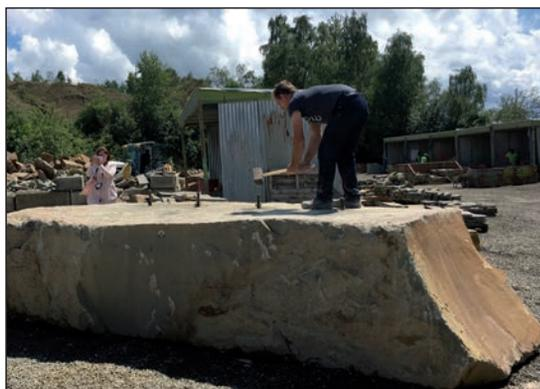
Figure 1.7 – Fendage d'un bloc de grès
