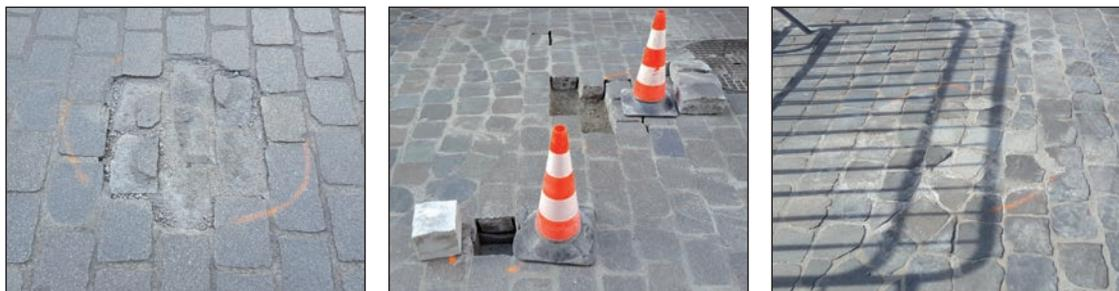
**Figure 5.18** – Réparer à temps les dégradations locales des revêtements modulaires en pierre naturelle en remplaçant des éléments détériorés (Photos: Febenat)
