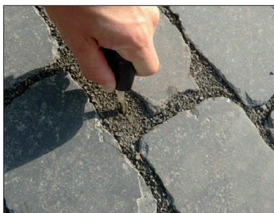
**Figure 3.25** – Exemple d'un bon jointolement avant l'ouverture au trafic
