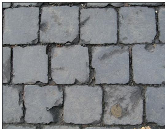
**Figure 5.3** – Exemple de cassure ou d'effritement aux bords des pavés, à cause de joints trop étroits
