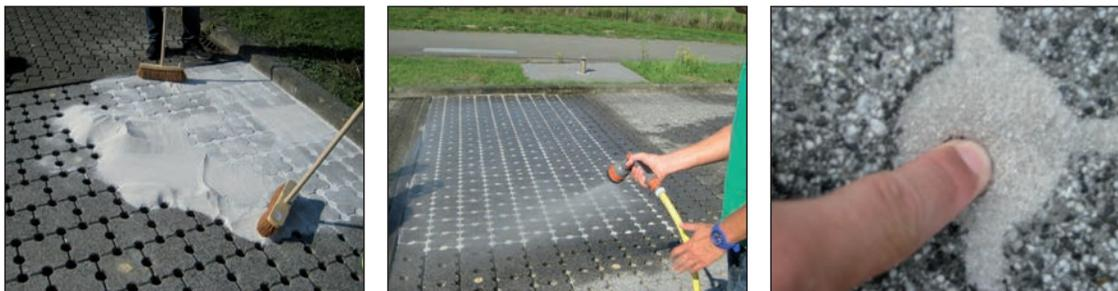
Figure 2.13 – Principe du sable polymère
