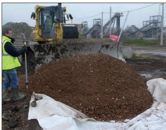
**Figure 3.2** – Pose d'un géotextile anticontaminant sous la sous-fondation
