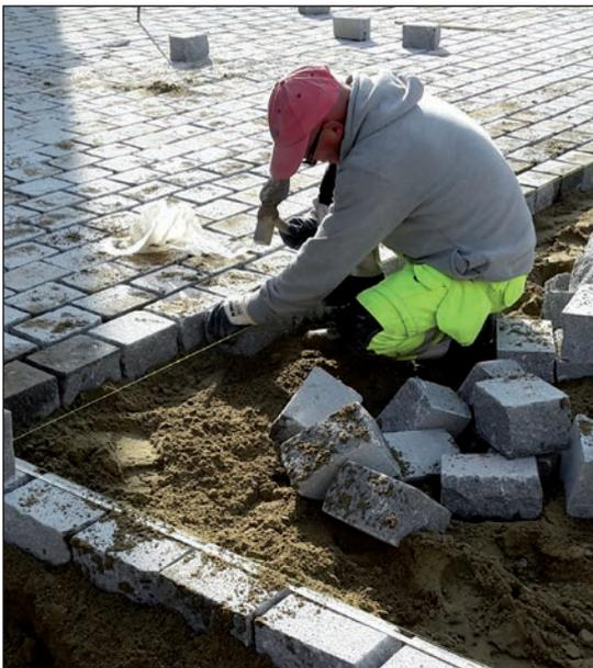
**Figure 4.6** – Pose de pavés avec contrôle visuel de la linéarité des joints
