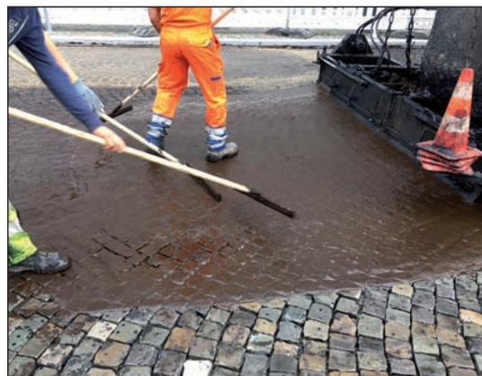
Figure 2.12 – Mise en œuvre de mortier bitumineux
