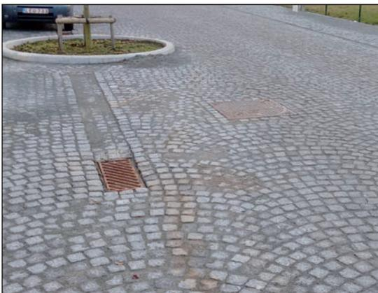
Figure 4.10 – Exemple de pose autour de points singuliers
