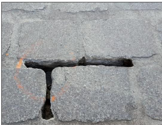
**Figure 5.17** – Dégradation locale aux joints dans un revêtement modulaire en pierre naturelle (Photo: Febenat)
