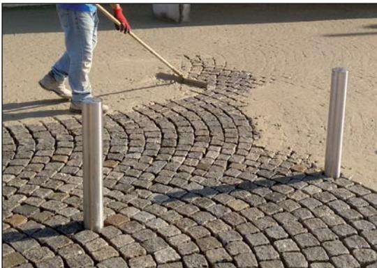
**Figure 4.13** – Remplissage des joints au mortier modifié
