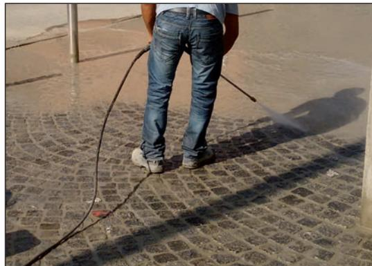
**Figure 4.14** – Nettoyage des pavés après remplissage des joints
