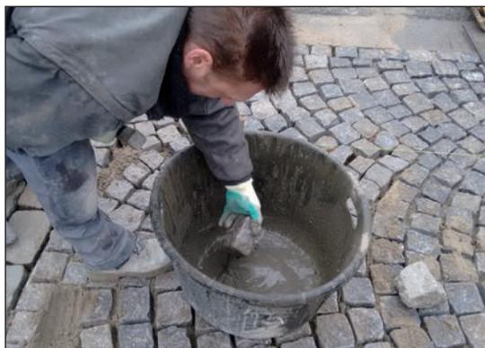
**Figure 4.18** – En haut: application d'une couche d'adhérence (Haftbrücke) entre la couche rigide et la pierre naturelle au droit des joints de dilatation, telle qu'appliquée en Allemagne. En bas: exemple du trempage des pavés au droit du joint de dilatation
