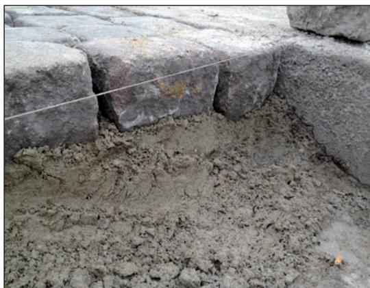
**Figure 2.8** – Couche de pose en sable-ciment
