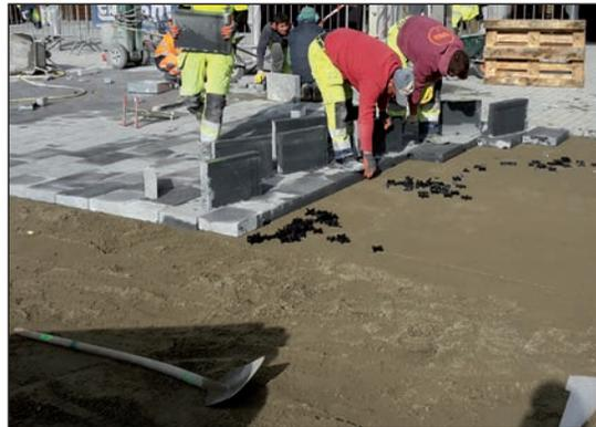
Figure 4.22 – Profilage et égalisation du lit de mortier pour dalles en pierre naturelle
