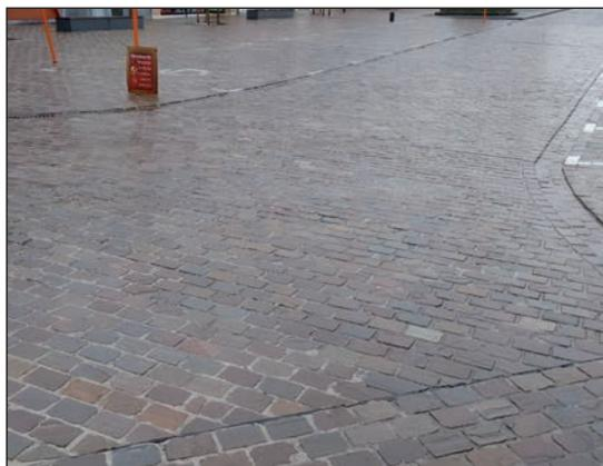
**Figure 4.9** – Orientation des joints continus perpendiculairement à la direction du trafic
