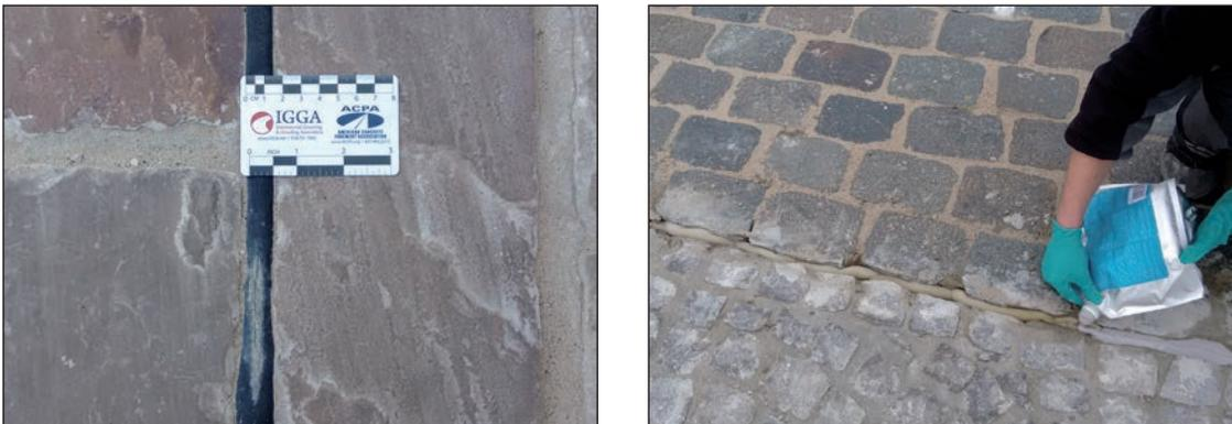
Figure 4.17 – Mise en œuvre de joints de dilatation
