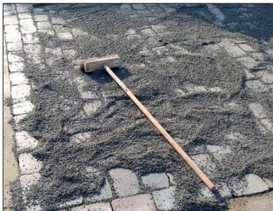
**Figure 2.10** – Jointoiement au porphyre concassé 2/4
