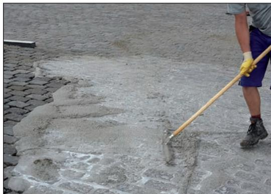
**Figure 4.16** – Remplissage des joints au mortier lié à la résine epoxy
