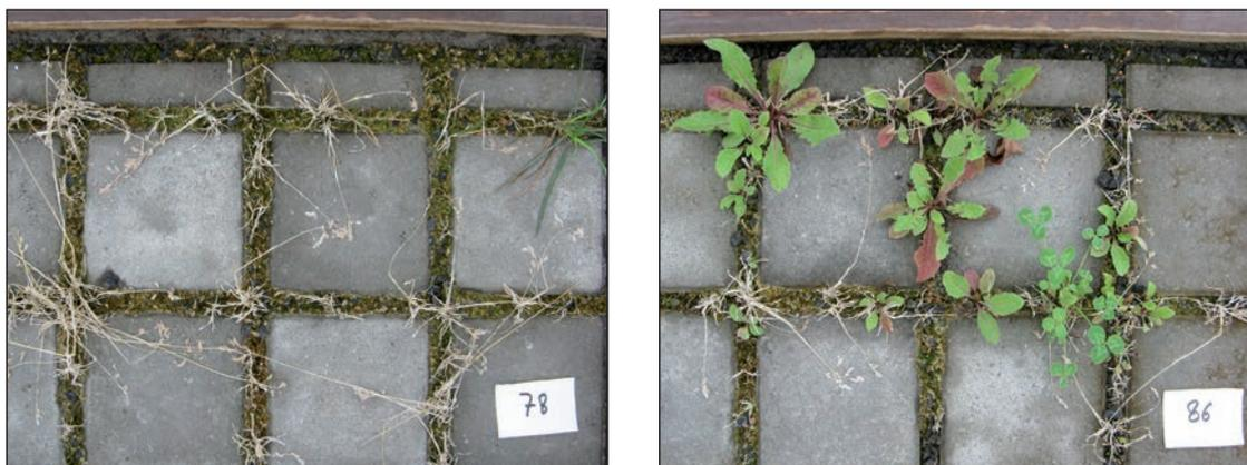
**Figure 5.15** – Influence du matériau de couche de pose sur l'apparition des mauvaises herbes dans un jointoiment de calcaire pollué 0/6,3 – A gauche: couche de pose ouverte de porphyre 2/6,3; à droite: couche de pose fermée de calcaire 0/6,3)
