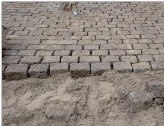
**Figure 5.20** – Réutilisation d'anciens pavés en cas de reconstruction complète d'un pavage en pierre naturelle
