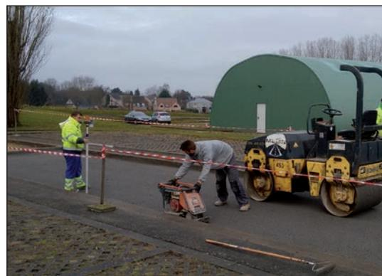
**Figure 4.4** – Importance d'une bonne planéité et d'un profilage de la fondation
