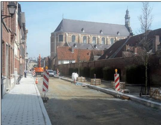
**Figure 4.2** – Pose des éléments de contrebutage avant la fondation et la couche de pose
