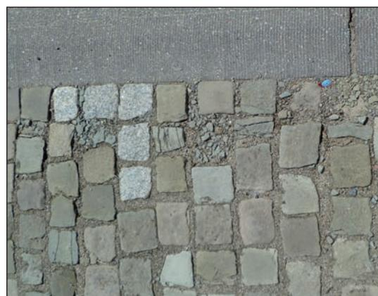
**Figure 5.1** – Exemple d'éclatement ou de désintégration de certains types de pierre naturelle en raison des conditions climatiques et/ou de la charge de trafic
