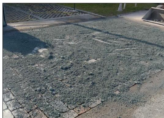
**Figure 4.12** – Compactage des pavés humidifiés, suivi du remplissage des joints
