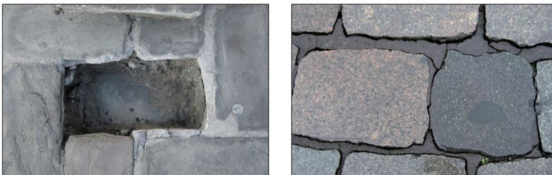
**Figure 5.9** – Réparation plus difficile lors de l'exécution selon le mode de pose rigide
