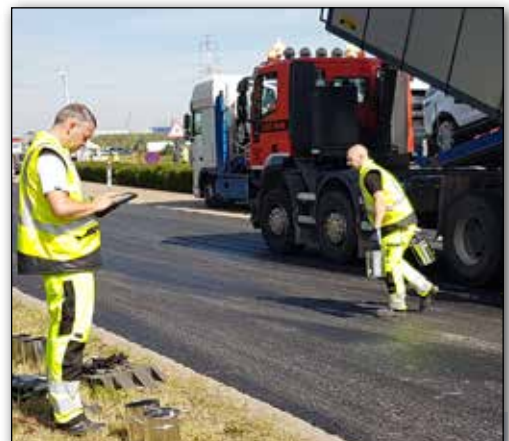
Figuur 2 – Het nemen van proefmonsters tijdens de aanleg van proefvakken met gebruik van verjongingsmiddel op de Steenlandlaan (Haven van Antwerpen) te Kallo/Beveren
