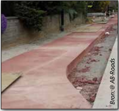
Figuur 6 – Vlakheidscoëfficiënt ( VC_{0,5} ) gemeten op fietspad, met inwerking van bushalte. Zone 1 is machinaal uitgevoerd, zone 2 handmatig
