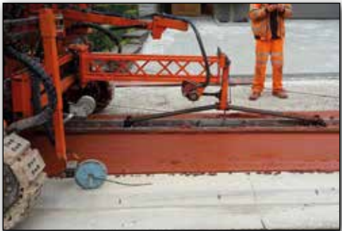
Figuur 8 – Gebruik van supersmoother bij aanleg van een betonnen fietspad
