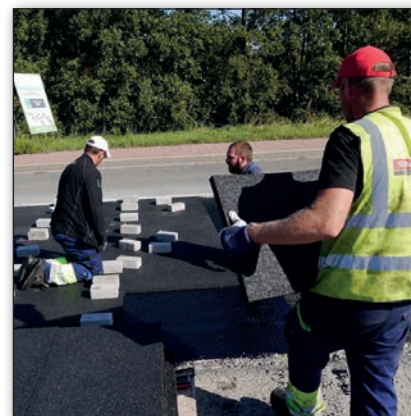
Metingen tijdens een testrit over het poro-elastische proefvak toonden een geluidsreductie van 7 tot 9 dB aan
