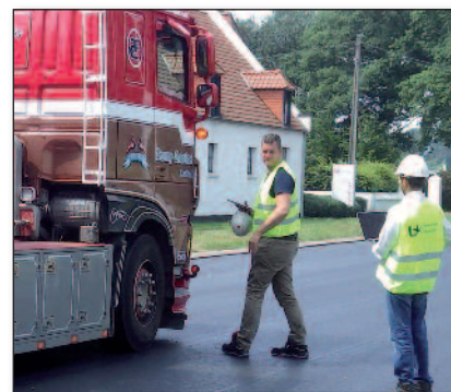
Figuur 4 – De vrachtwagen komt aan op de bouwplaats en wordt aangemeld in het systeem
