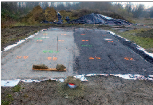
Figuur 5 – Op het tweede APERROUT-proefvak werden de prestaties van betonpuinsteenslag (links) en kalksteenslag (rechts) vergeleken
