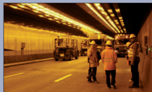
Figuur 3 – Rijdende inspectie overdag (boven) en inspectie te voet 's nachts (onder)
