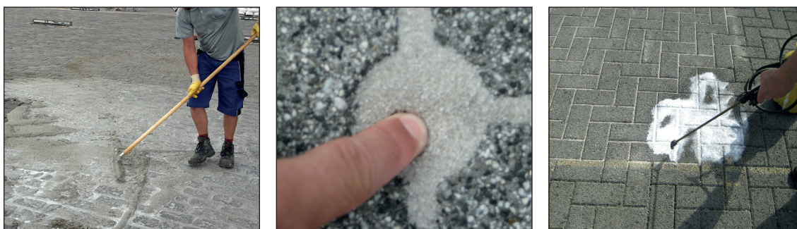
Figure 3 – Exemples de matériaux de jointoiment (plus) innovants (de gauche à droite: mortier de jointoiment lié à l'époxy, sable polymère et joint sealer)
