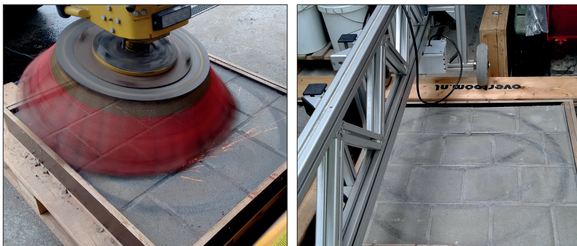
Figure 27 – Essais de sensibilité à l'érosion des mortiers de jointoiment (brosse de désherbage en acier et profilomètre laser pour déterminer les profils de joint avant et après brossage)
