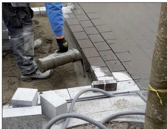
Figuur 2.14 – Aanbrengen van een hechtlaag
