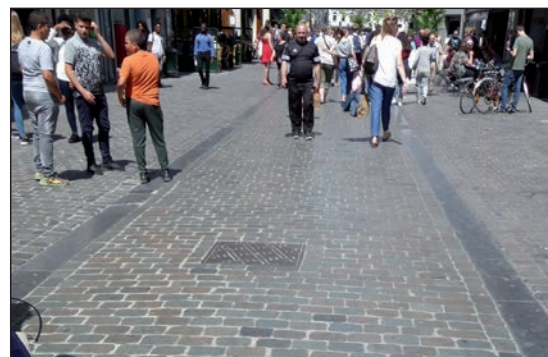
Figuur 3.31 – Comfortabele inrichting voor fietsers (rijbaan met gezaagde straatkeien), maar niet voor voetgangers (trottoir met platineststraatkeien)
