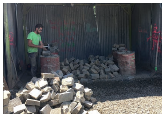
Figuur 1.9 – Behouwen en vlakken van zandsteenblokken
