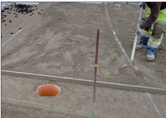
Figuur 4.22 – Profileren en effenen van een mortelbed voor natuursteentegels
