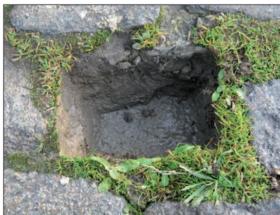
Figuur 5.10 – Voorbeelden van schade door gebrekkige waterafvoer van de natuursteenverharding
