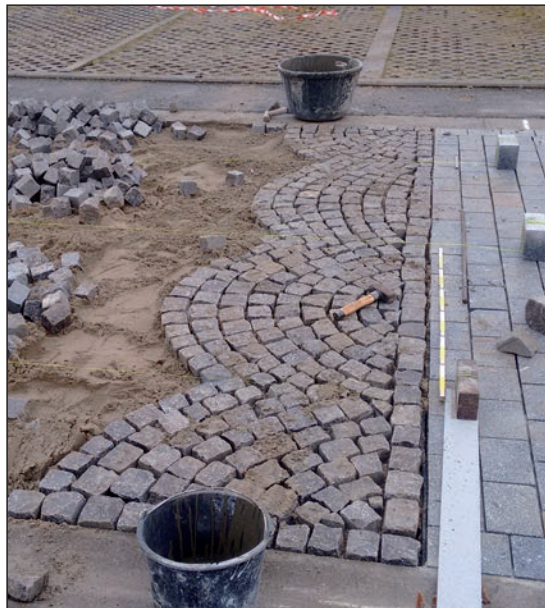
Figuur 4.7 – Aanbrengen van een streklaag
