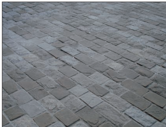
Figuur 3.27 – Weinig comfortabele natuursteenbestrating door de vele onvlakheden 5
