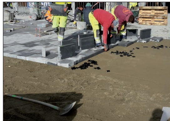
Figuur 4.22 – Profileren en effenen van een mortelbed voor natuursteentegels
