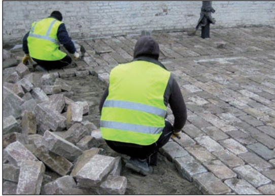
Figuur 4.5 – Inbedden van straatkeien in een straatlaag, gevolgd door verdichting
