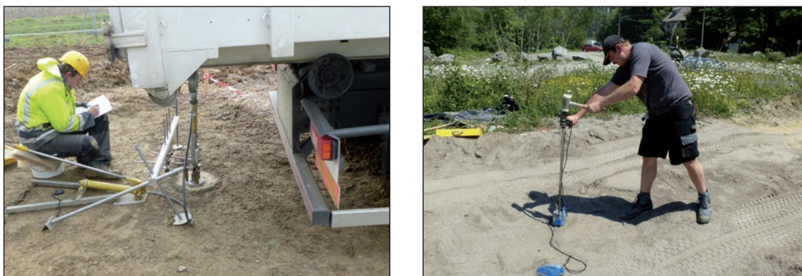
Figuur 3.3 – Geotechnische proeven voor en tijdens de werken (plaatbelastingsproef en proef met het PANDA-apparaat)
