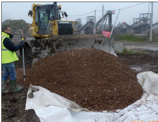
Figuur 3.2 – Aanbrengen van een scheidend geotextiel onder de onderfundering
