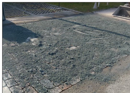
Figuur 4.12 – Verdichten van bevochtigde straatkeien, waarna de voegen worden gevuld
