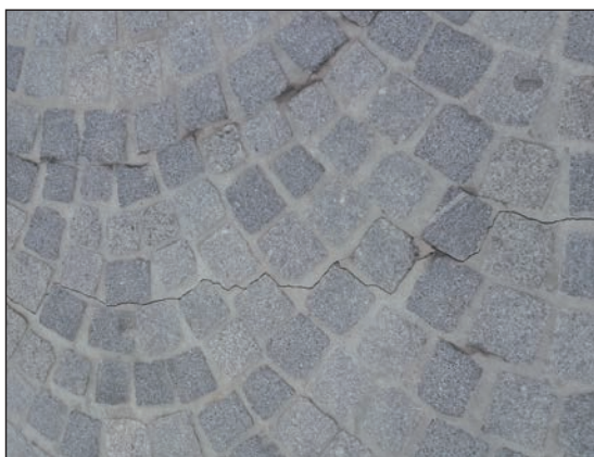
Figuur 5.5 – Barsten in cementgebonden voegen zijn een vaak voorkomend schadebeeld waaraan een hele rist oorzaken ten grondslag kan liggen
