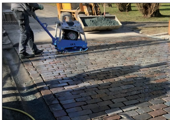
Figuur 4.12 – Verdichten van bevochtigde straatkeien, waarna de voegen worden gevuld
