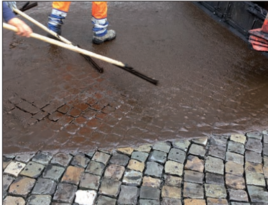
Figuur 4.15 – Vullen van voegen met bitumineuze mortel
