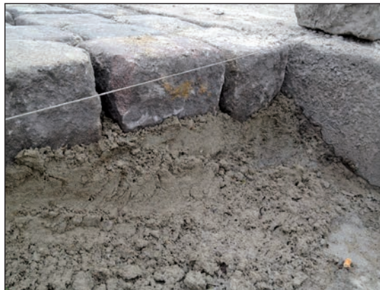
Figuur 2.8 – Straatlaag van zandcement
