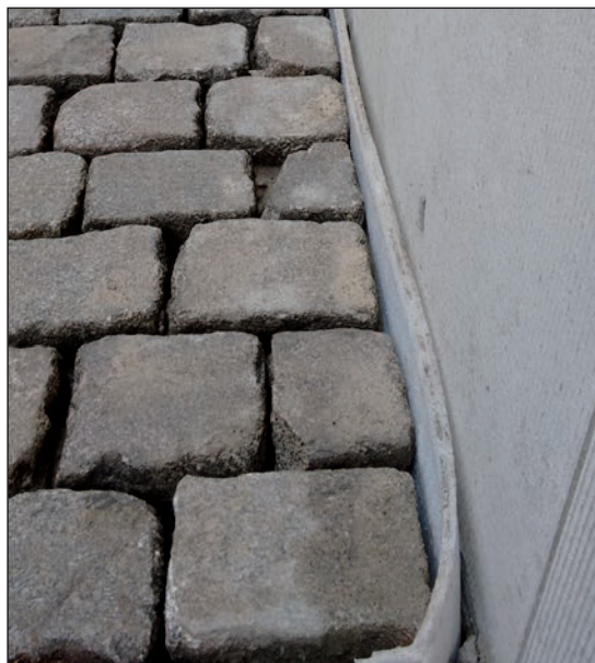
Figuur 3.20 – Isolatievoeg tussen een muur van een woning en een trottoir
