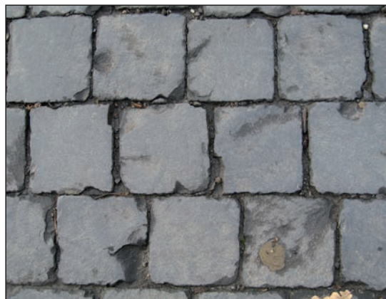
Figuur 5.3 – Voorbeeld van breken of afbrokkeling aan de randen van straatkeien, door te smalle voegen
