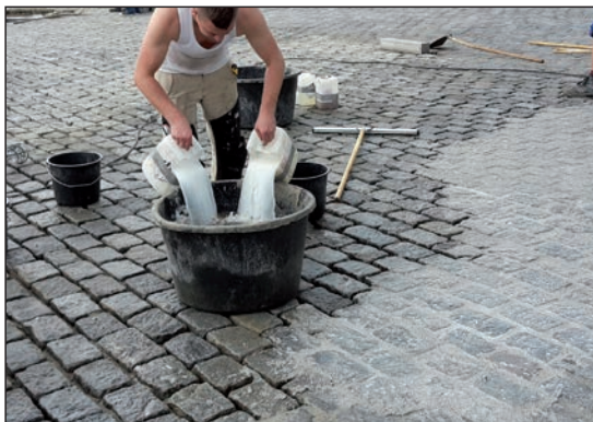
Figuur 4.16 – Vullen van voegen met epoxyharsgebonden mortel
