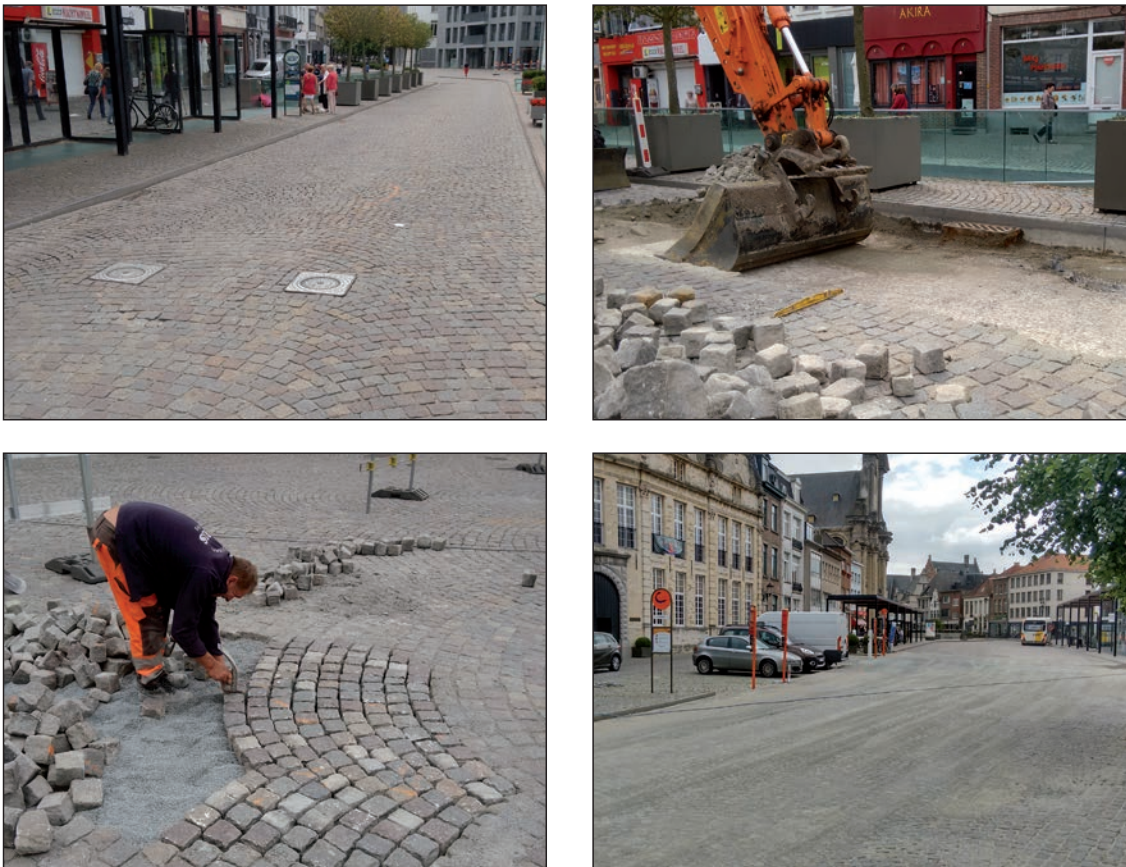
Figuur 5.21 – Natuursteenbestrating voor, tijdens en na renovatie met hergebruik van bestaande straatkeien van Zweeds graniet
