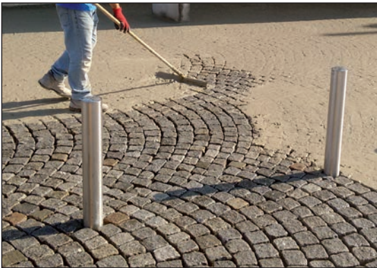
Figuur 4.13 – Vullen van voegen met gemodificeerde mortel
