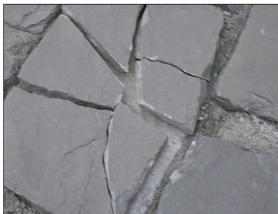
Figuur 5.1 – Voorbeeld van afsplijting of desintegratie van bepaalde natuursteensoorten onder klimatologische en/of verkeersbelasting
