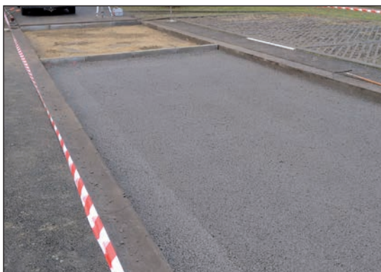
Figuur 4.4 – Belang van goede vlakheid en juiste profilering van fundering
