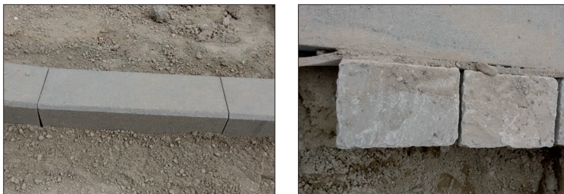
Figuur 4.20 – Aanbrengen van trottoirbanden en isolatievoeg (rechts) tussen trottoirband en straatkeien
