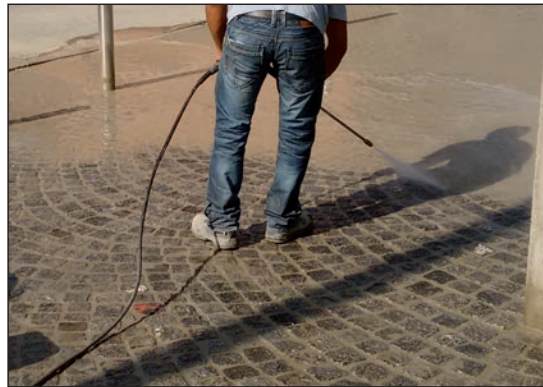
Figuur 4.14 – Schoonmaken van de bestrating nadat de voegen zijn gevuld
