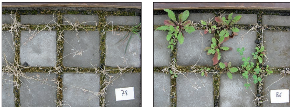
Figuur 5.15 – Invloed van straatlaagmateriaal op onkruidgroei in een voegvulling van vervuilde kalksteen 0/6,3 - Links: open straatlaag van porfier 2/6,3; rechts: gesloten straatlaag van kalksteen 0/6,3
