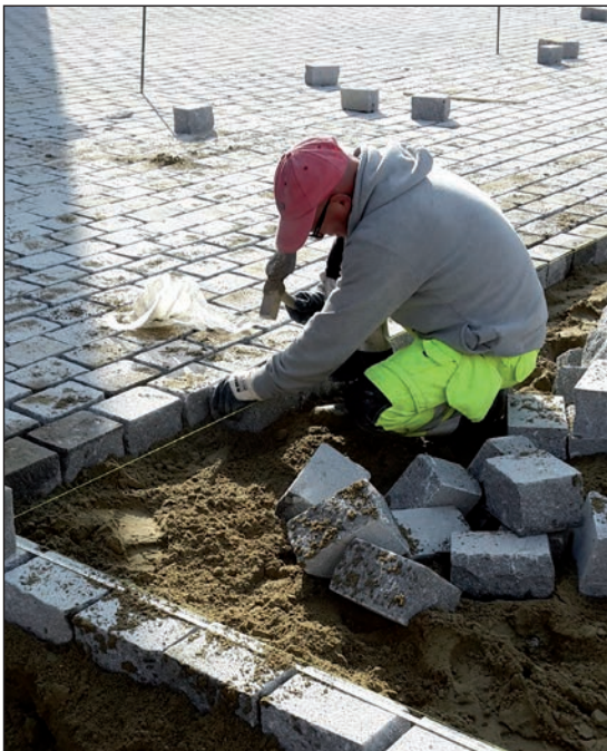
Figuur 4.6 – Aanbrengen van straatkeien met visuele controle van de rechtlijnigheid van de voegen
