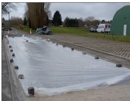
Figuur 4.1 – Voorbeeld van bescherming van een natuursteenverharding bij ongunstige weersomstandigheden
