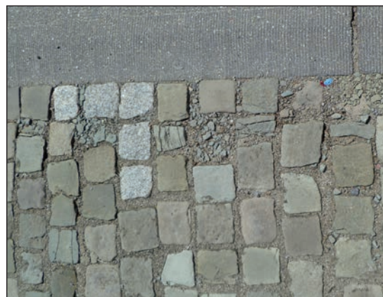
Figuur 5.1 – Voorbeeld van afsplijting of desintegratie van bepaalde natuursteensoorten onder klimatologische en/of verkeersbelasting
