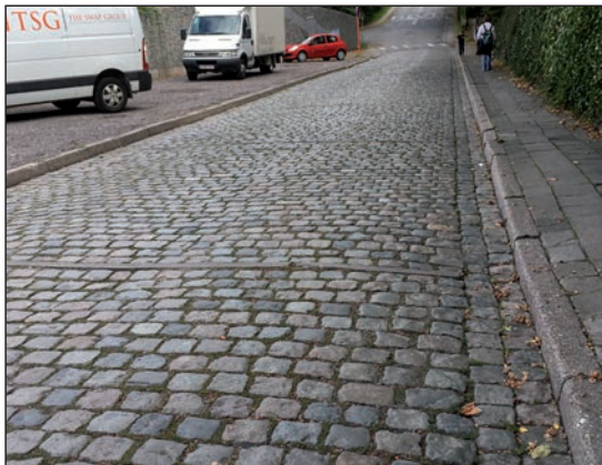
Figuur 4.3 – Voorbeeld van overdwarse opsluiting in een hellende straat
