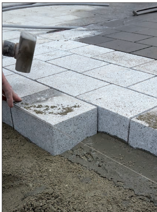
Figuur 4.23 – Aanbrengen van gezaagde natuurstenen straatkeien met een “hechtlaag” tussen straatlaag en straatkei
