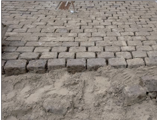
Figuur 5.20 – Hergebruik van oude straatkeien bij volledige heraanleg van een natuursteenbestrating
