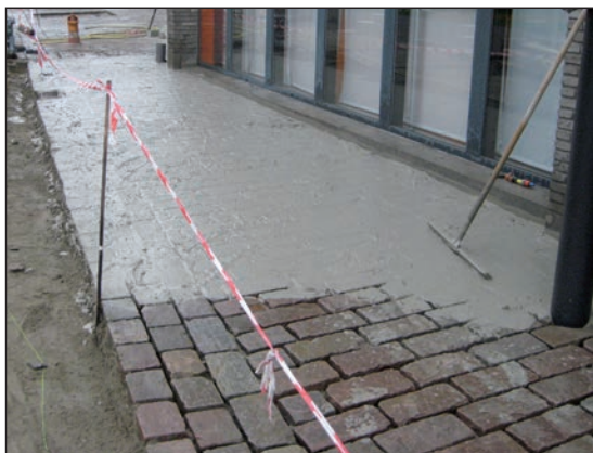
Figuur 2.11 – Aanbrengen van gemodificeerde mortel
