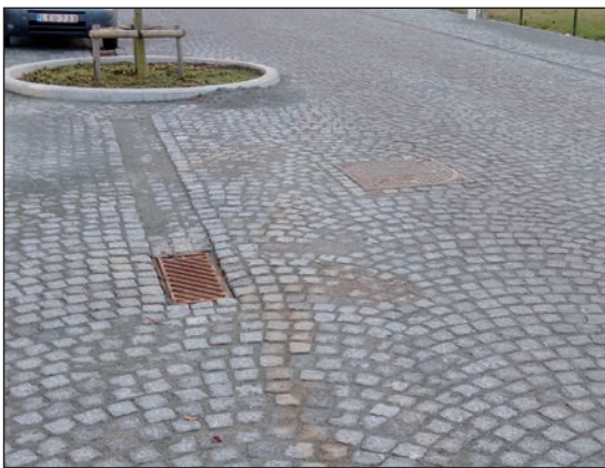
Figuur 4.10 – Voorbeeld van straatwerk rond singuliere punten
