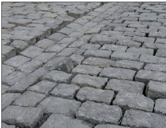
Figuur 3.17 – Voorbeeld van onverenigbaarheid tussen voeg- en straatlaagmateriaal: combinatie van een stijve straatlaag van zandcement met flexibele, doorlatende zandvoegen, waarbij de straatkeien los komen te liggen onder invloed van water, vorst en verkeer
