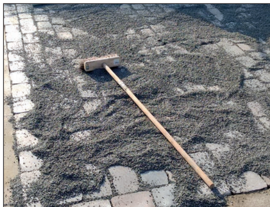
Figuur 2.10 – Voegvulling van gebroken porfier 2/4
