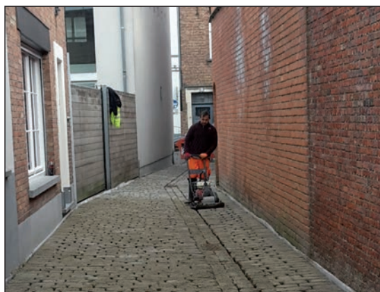
Figuur 4.11 – Goed afrillen van bestrating, ook aan de randen
