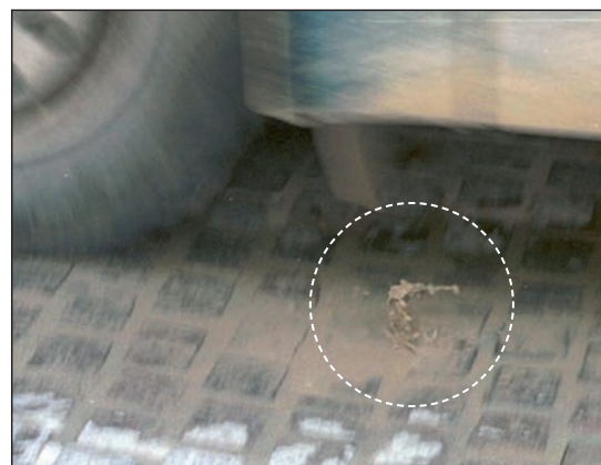
Figuur 5.10 – Voorbeelden van schade door gebrekkige waterafvoer van de natuursteenverharding
