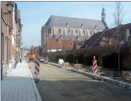
Figuur 4.2 – Aanbrengen van kantopsluitingen voordat de fundering en de straatlaag worden aangebracht
