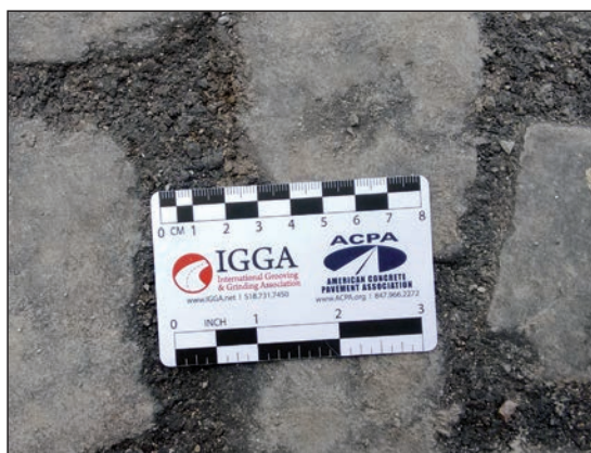
Figuur 2.12 – Aanbrengen van bitumineuze mortel
