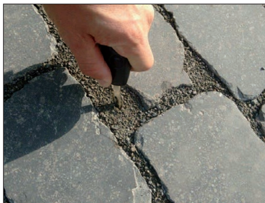
Figuur 3.25 – Voorbeeld van goede voegvulling voordat verkeer wordt toegelaten
