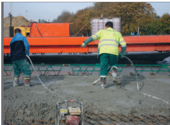
Figuur 3.16 Verwerking tussen vaste bekisting met verdichting door trilbalk en trilnaalden
