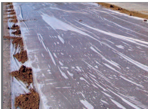
Figuur 3.26 Bescherming beton door plasticfolie
