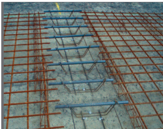
Figuur 3.13 Combinatie van wapeningsnet en deuvels
