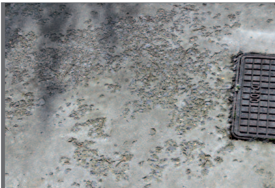
Figuur 6.8 Afschilfering aan oppervlak ten gevolge van dooizouten
