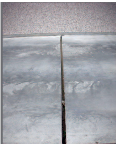
Figuur 3.3 Uitgezaagde uitsparing voor plaatsing uitzetvoeg
