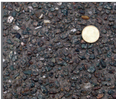
Figuur 3.23 Fijn uitgewassen textuur
