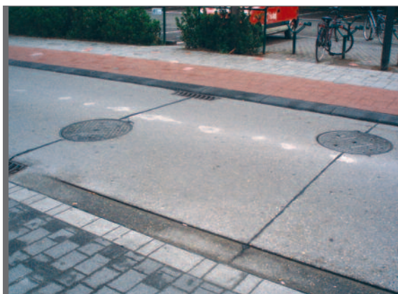
Figuur 3.11 Zaagsneden ter hoogte van singuliere punten
