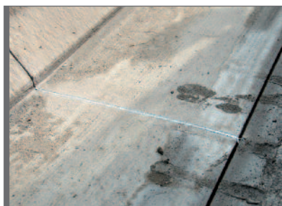
Figuur 3.9 Een component koud gegoten voegvullingsmateriaal
