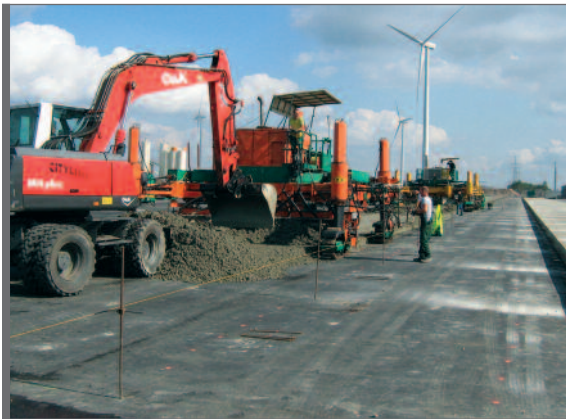
Figuur 3.15 Aanleg tweelaags beton met glijbekistingmachine
