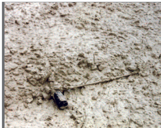
Figuur 3.14 Gedeuveld platenbeton met staalvezelbeton
