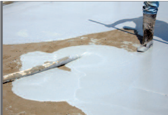
Figuur 4.1 Slijtlaag, «nat in nat» geplaatst
