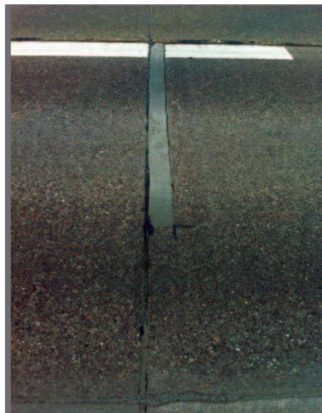
Figuur 6.13 Herstellen van een plaatrand met behulp van herstelmortel
