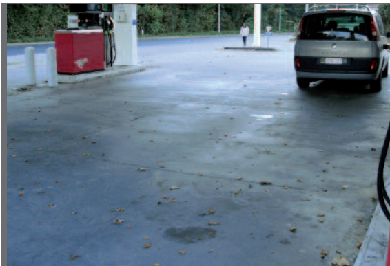
Figuur 4.3 Vloeistofdichte verharding
