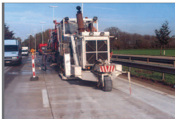
Figuur 6.15 Afslijpen met diamantschijven
