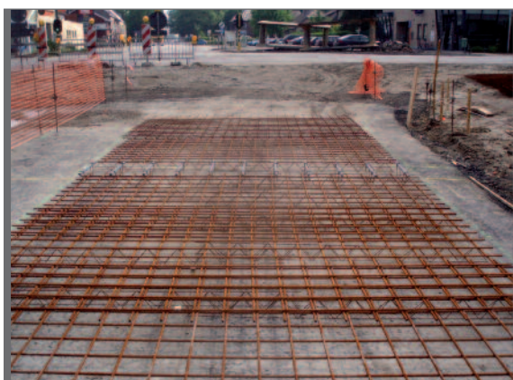
Figuur 1.2 Gewapend platenbeton
