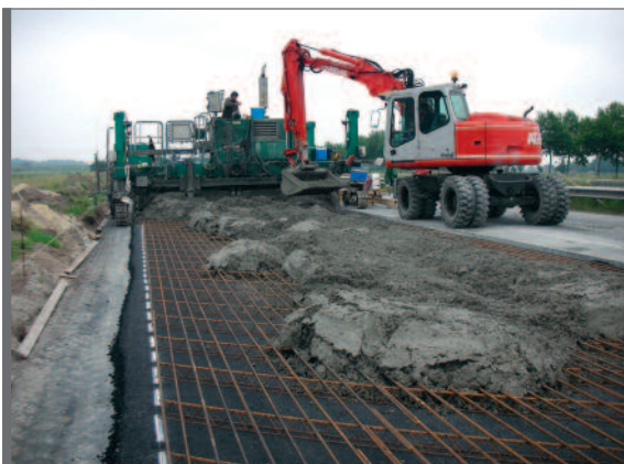
Figuur 1.4 Verharding in doorgaand gewapend beton
