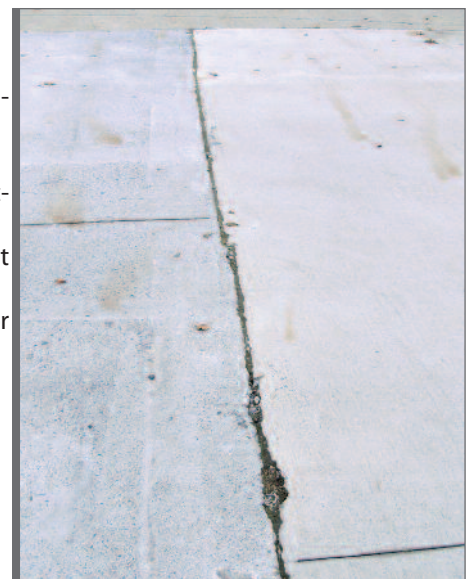
Figuur 6.7 Uitbrokkelen van voegranden
