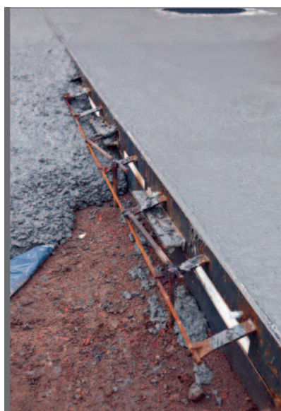
Figuur 3.7 Geprefabriceerd voegsysteme (recht profiel)
