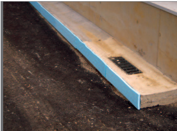
Figuur 3.2 Uitzetvoeg/isolatievoeg
