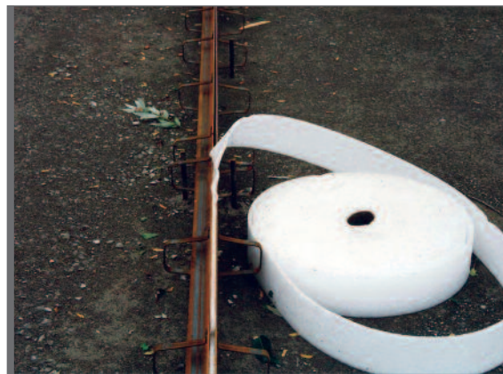
Figuur 3.6 Voegsysteme als uitzetvoeg
