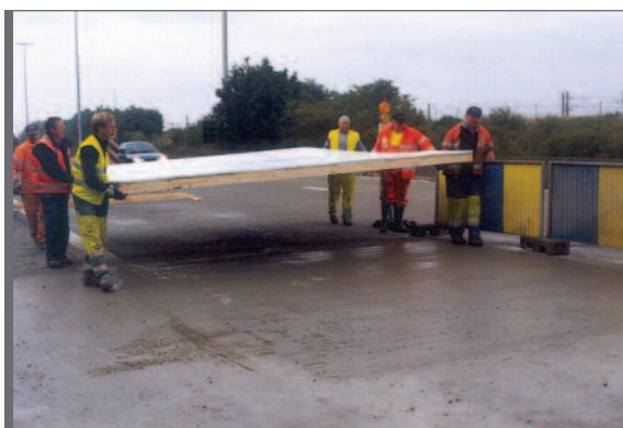
Figuur 3.28 Isolerende plaat op beton
