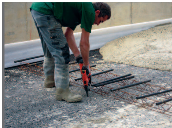
Figuur 3.5 Vastzetten van deuvelstoelen in fundering voor aanbrennen deuvels in dwarse krimpvoeg
