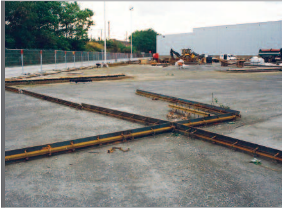
Figuur 1.7 Fundering als effen draagvlak voor verharding na plaatsing uitzetvoegen
