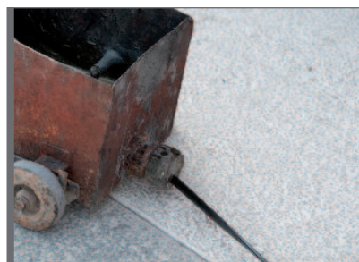
Figuur 3.10 Voorgevormd voegvullingsprofiel
