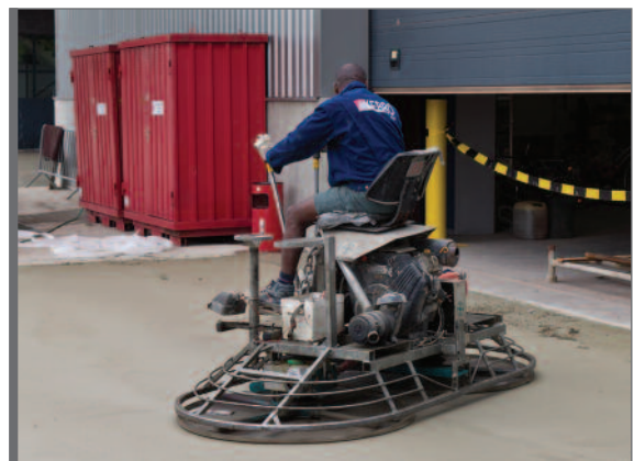
Figuur 3.20 Machinale helikopterafwerking
