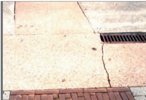
Figuur 6.1 Scheur ten gevolge van verkeerd voegenpatroon
