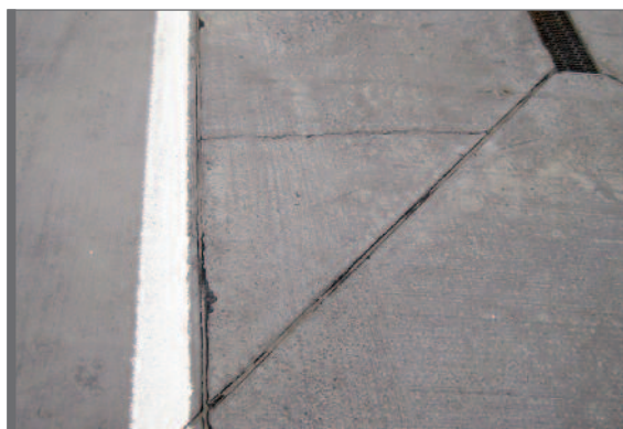
Figuur 6.3 Scheur ten gevolge van scherpe hoek
