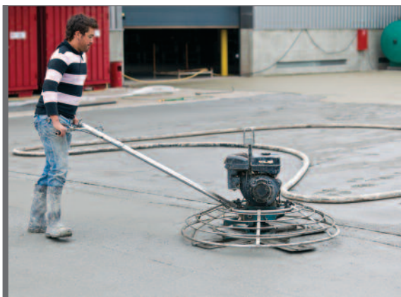
Figuur 3.19 Manuele helikopterafwerking
