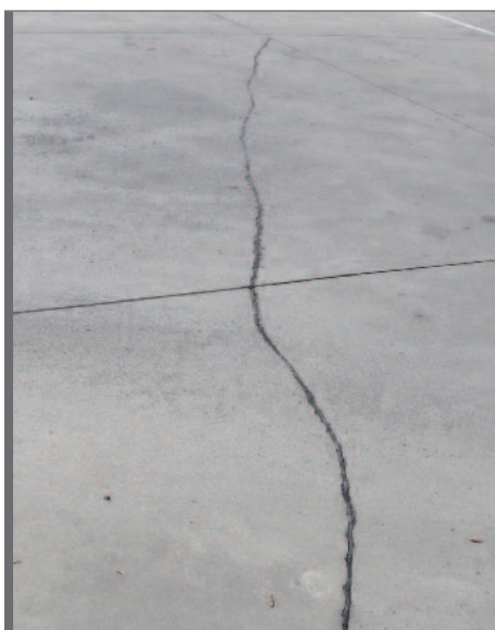
Figuur 6.12 Afdichten van scheuren
