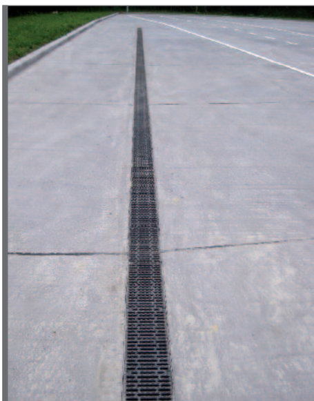
Figuur 3.29 Afvoergoot in polymeerbeton
