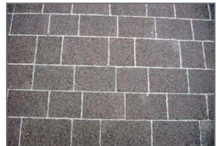
Figuur 1.8 Goede voegvulling voor opentelling voor verkeer
