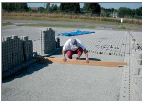
Figuur 6.2 Afstrijken van straatlaag met speciaal gezaagde balk
