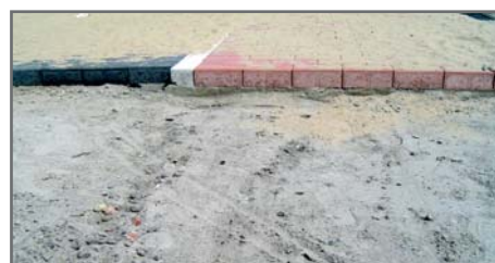
Figuur 1.4 Fundering met straatlaag, straatstenen en voegmateriaal
