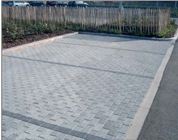
Figuur 1.12 Boordsteen bij overgang tussen straatstenen en asfaltverharding
