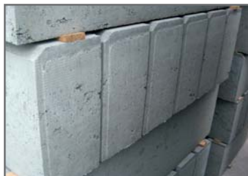
Figuur 4.3 Splintervrije kopse zijde van kantopsluiting
