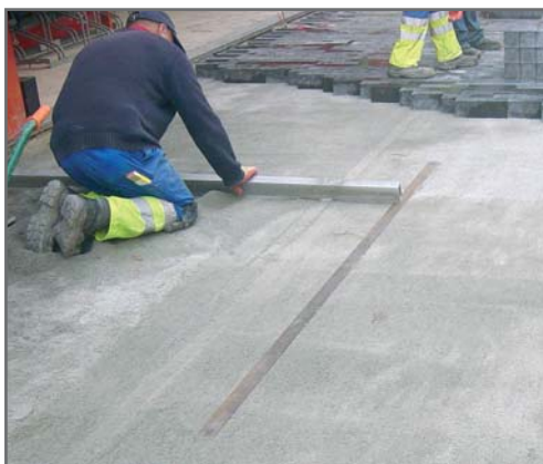
Figuur 4.6 Profileren van straatlaag met behulp van stellatten
