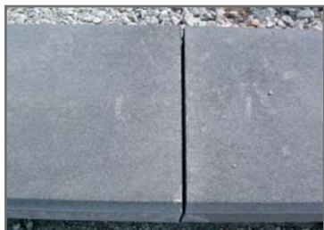
Figuur 4.3 Splintervrije kopse zijde van kantopsluiting
